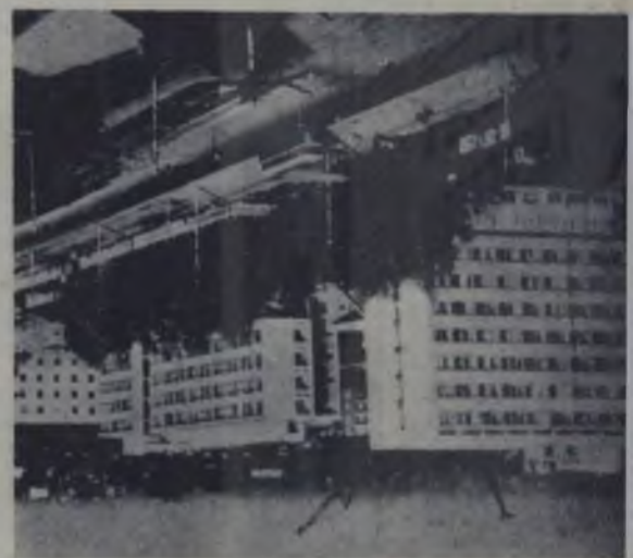
R. P. POLONĂ. — Construcții moderne în Piața Plac Grunwaldzki din Varșovia.
