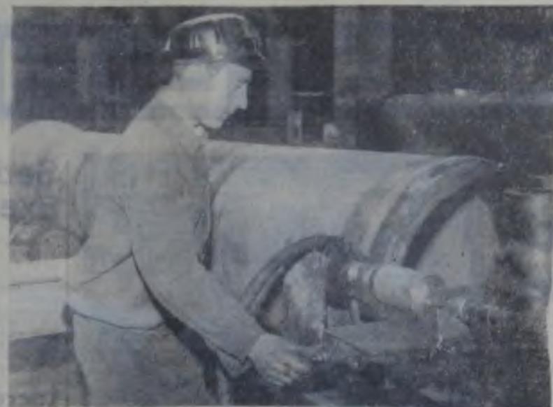
Primele tuburi de prefabricate din beton realizate în noua secție a întreprinderii de prefabricate din beton și primii pași în noua meserie făcută de rectificatorul Victor Petruș.
