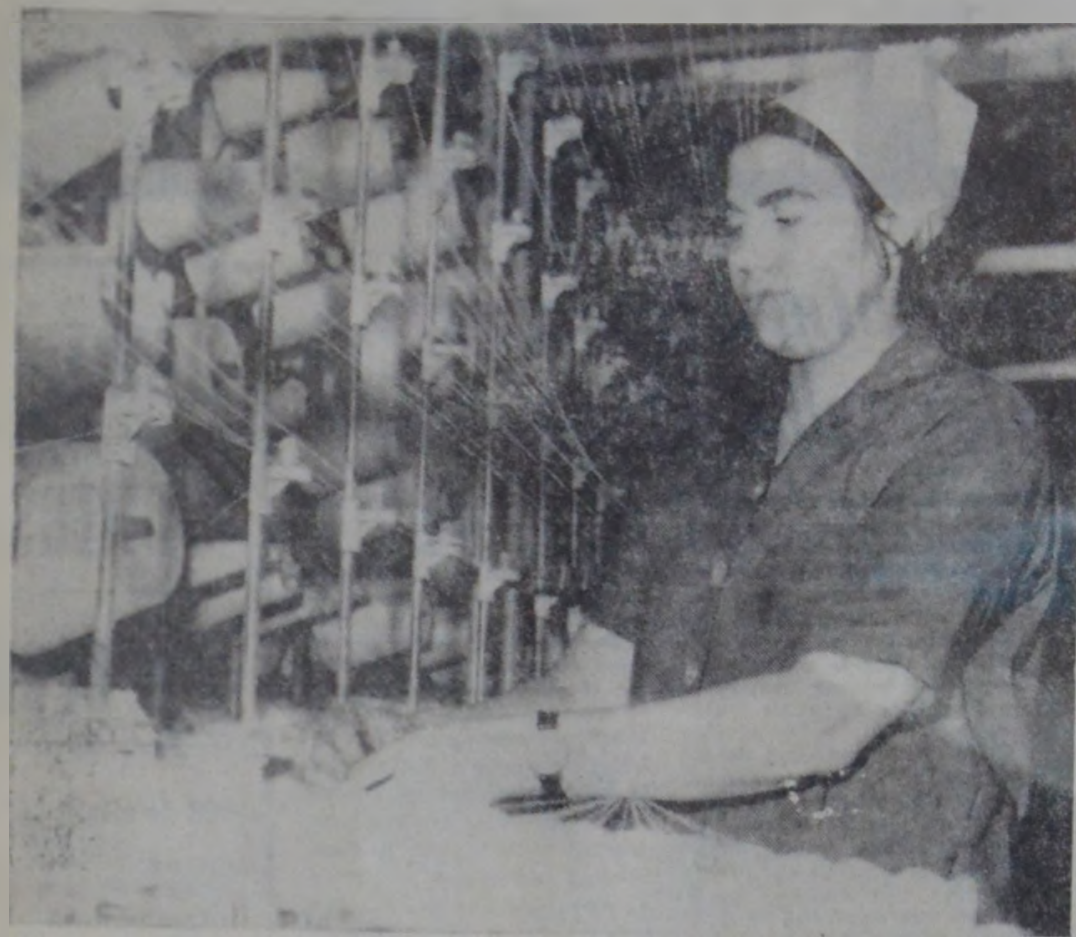
Fabrica „8 Martie” — Dintre primele operații ale fluxului tehnologic, face parte și urzitul, zecile de bobine se vor transforma sub supravegherea muncitorei Bucureștea Potolnică într-o bandă continuă de tricot.
