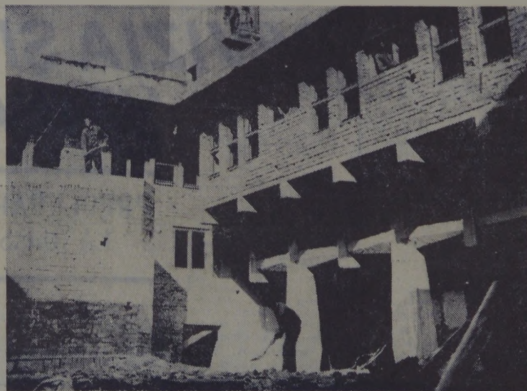
Lucrările de construcții de la Casa de cultură din Roman, în faza finală.
