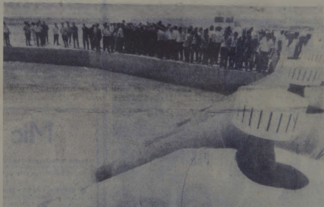
R.A.U. Sistem de pompare la una din cele 3 stații de pompare acționate cu energie electrică de la hidrocentrala de la Assuan, care pompează apa din Nil și o distribuie prin canalele de irigație.
