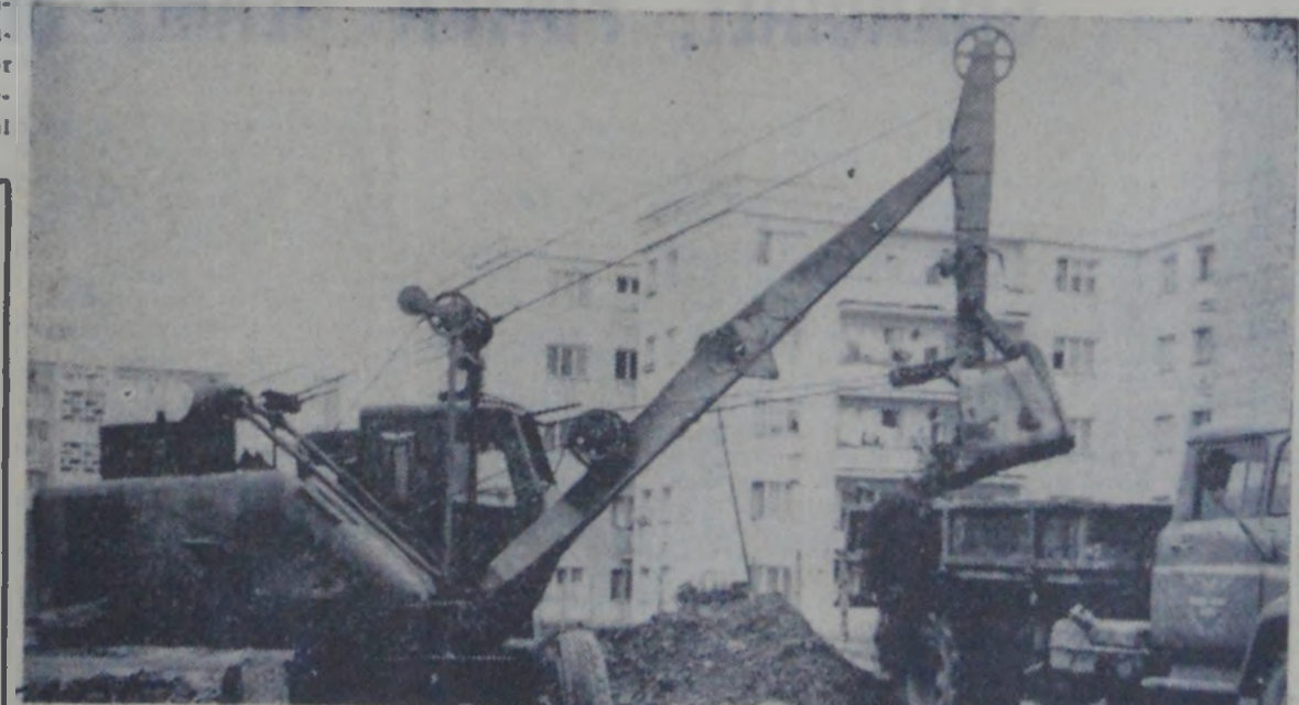
Se lucrează la fundația de profunzime a noului complex comercial din cartierul „Precizia” din municipiul Piatra Neamț.
