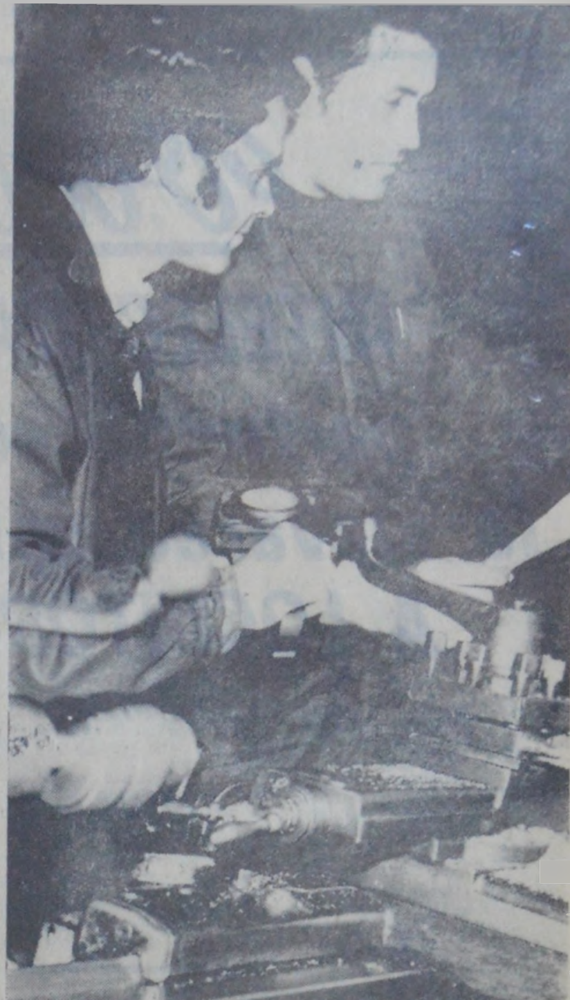
Clupe de apă caldă, necesare de confirmare în Căminul Constructiv, școlii de muncă românești. În imagine: un grup de muncitori și studenți la lucrările de rețecere și reparație.
