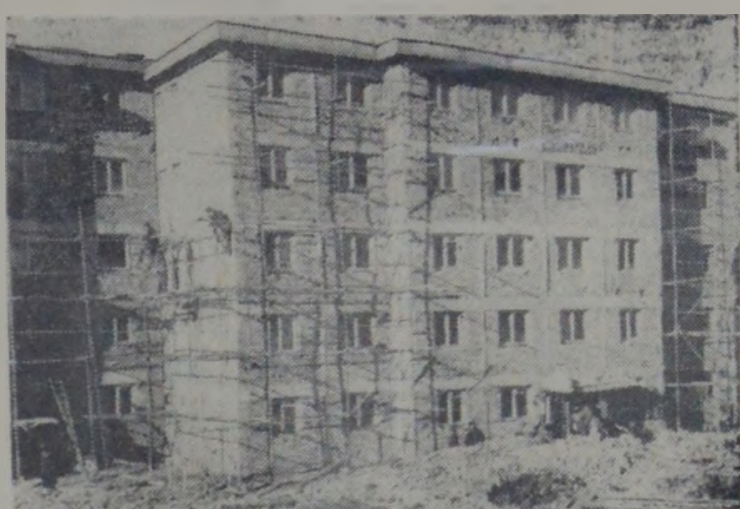
Blocul C-2 trebuie dat în folosință încă la 30 decembrie; la ora actuală se mai execută finisări.
