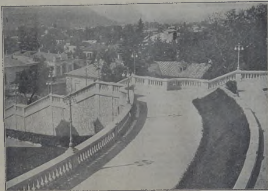
CENTRUL ORAȘULUI PIATRA-NEAMȚ, MODERNIZAT
