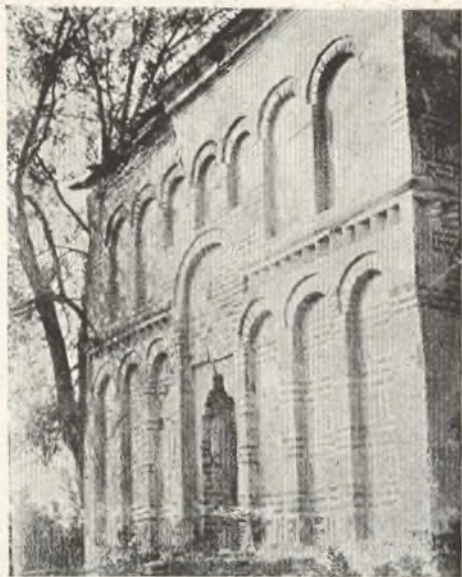
Fațada dela Apus a Bisericii.
